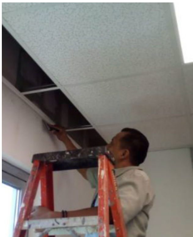
Reparación de filtraciones
