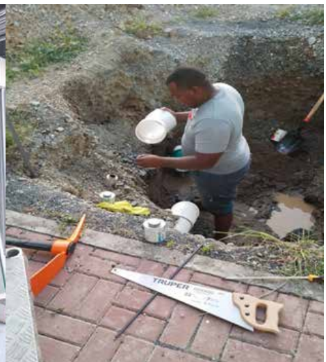
Reparación de filtraciones
